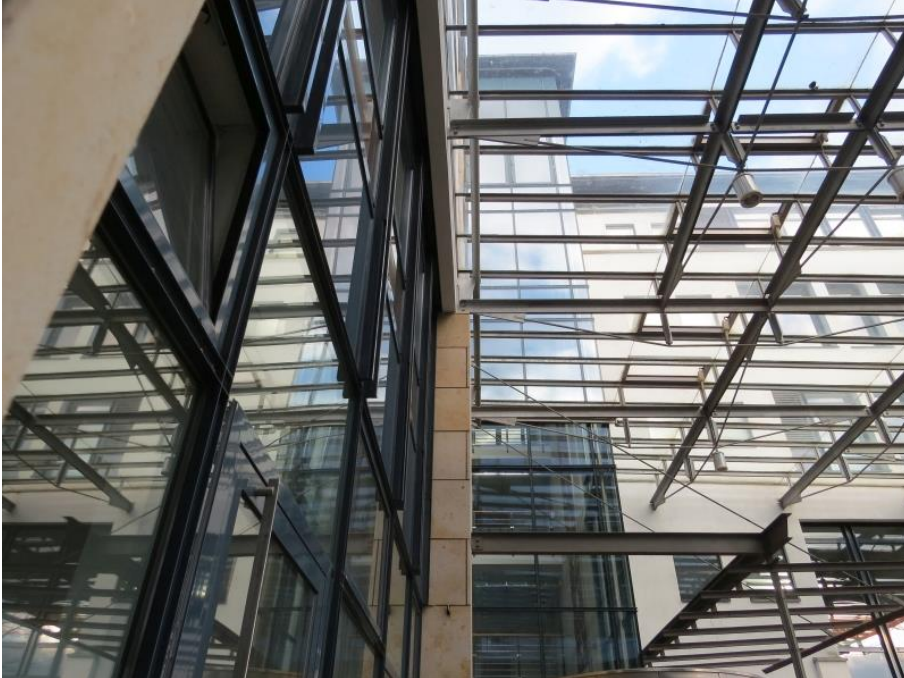
Nistplätze oberhalb der Natursteinverkleidung im Spalt am Fenster
