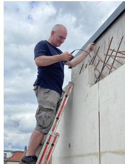
Unter der Attika und in Fassadenlöchern befinden sich Nistplätze. Mit Hilfe einer Endoskopkamera waren sie genau zu lokalisieren. Stahlstangen verletzten das Gefieder und hinderten die Mauersegler daran, die Nester mit den Jungen zu erreichen. Foto: NABU Leipzig
